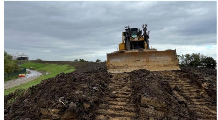
So wird es zehn Jahre lang zwischen dem Lühe-Anleger und Schöpfwerk Twielenfleth aussehen: Die Raupe modelliert hier satellitenunterstützt den neuen Deich in Stadersand, im Hintergrund liegt das schwimmende LNG-Terminal. Foto: Vasek
